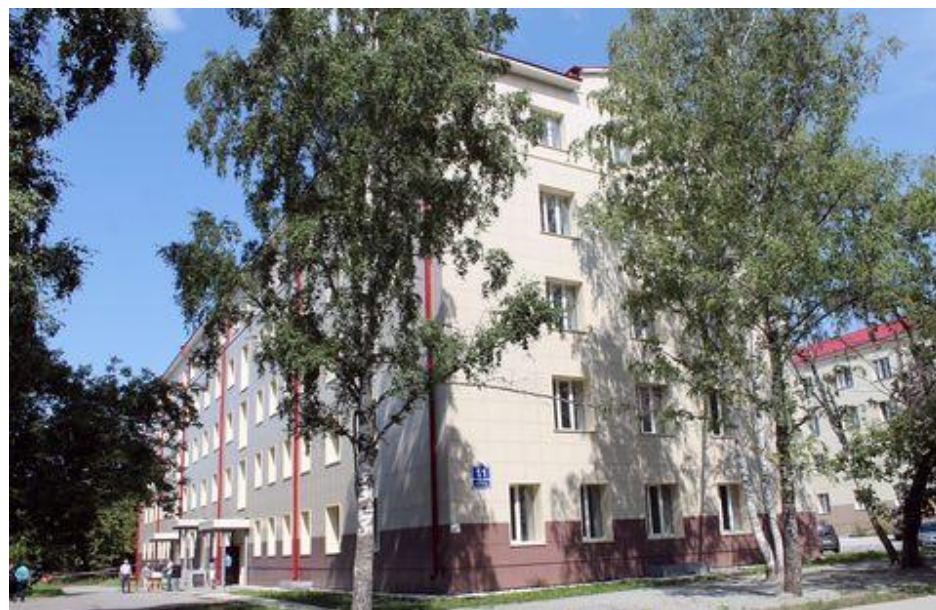
Дом на проспекте Строителей 11
